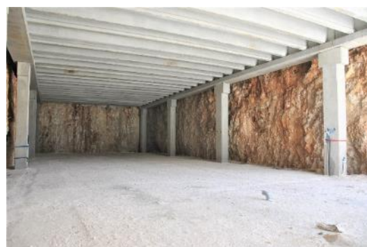
建築中のセラー
